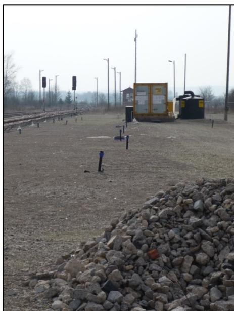
Die Deutsche Bahn saniert seit 2013 in einem aufwändigen Verfahren den Boden im Umfeld des früheren Entladegleises 9. Dort waren erhebliche Belastungen der Bodenluft durch Lösungsmittel festgestellt worden.
